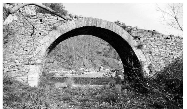
Η νότια πλευρά του γεφυριού
